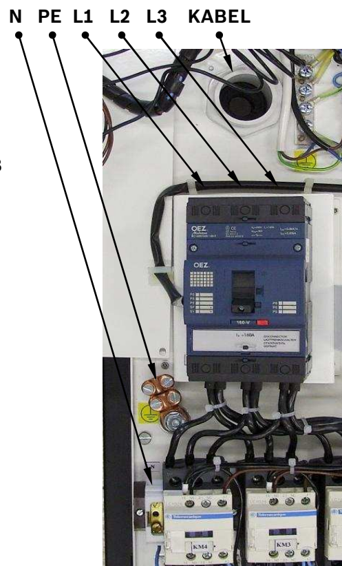
Obr. 20 Připojení přívodního kabel kotle Daline PTE 4 - 18
